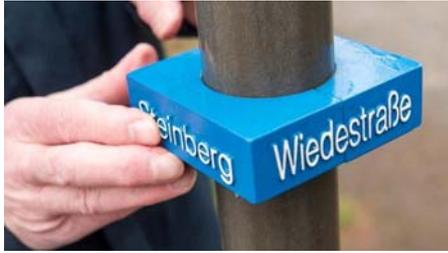
In 1,40 Meter Höhe, an bestehenden Straßenschildmasten angebracht, befinden sich blaue, quaderförmige Schilder aus Aluminium, auf denen sich in weißen, etwas erhabenen Lettern die Straßennamen befinden. Und zwar so angeordnet, dass der darauf angebrachte Straßename in die Richtung der passenden Straße zeigt.
